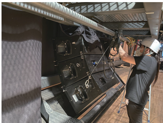
ポータル裏に仕込んだd&b Q1x3(L/C/R)
