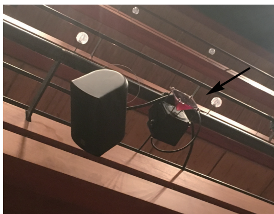
AFC Enhance用仮設ウォールスピーカー MEYER MM4 (リフレクター付) 右
