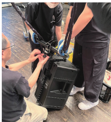
スピーカーの吊込み作業
