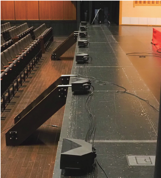
Rip-Fillに7台のNEXO ID24
